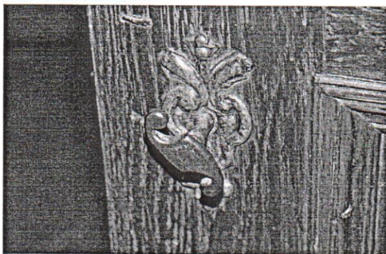
Fot. 3. Pomalowana i skorodowana klamka
